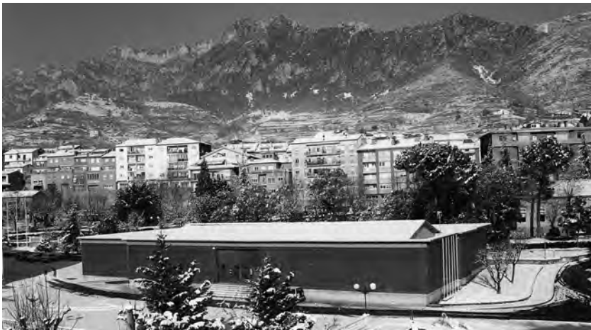
Edifici de l'Arxiu Comarcal del Berguedà
